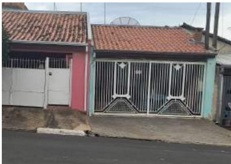
Figura 5: Fachada frontal da residência
