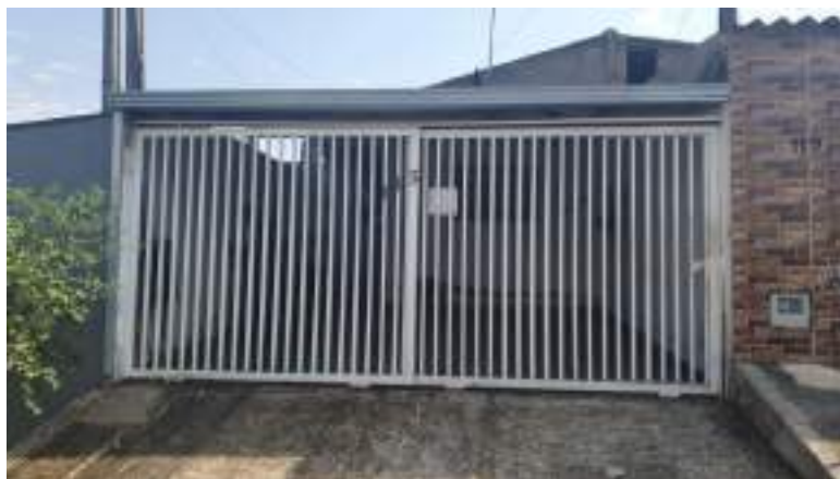
Figura 5: Fachada frontal da residência
